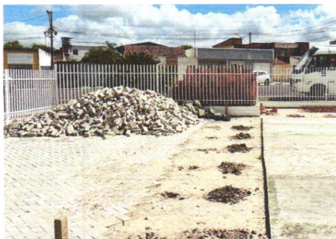
FOTO 01 - REMOÇÃO DE PISO DE BLOCO INTERTRAVADO OU DE PEDRA PORTUGUESA, DE FORMA MANUAL, COM REAPROVEITAMENTO. AF_09/2023
