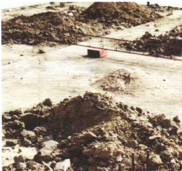
FOTO 01 - REMOÇÃO DE PISO DE BLOCO INTERTRAVADO OU DE PEDRA PORTUGUESA, DE FORMA MANUAL, COM REAPROVEITAMENTO. AF_09/2023
