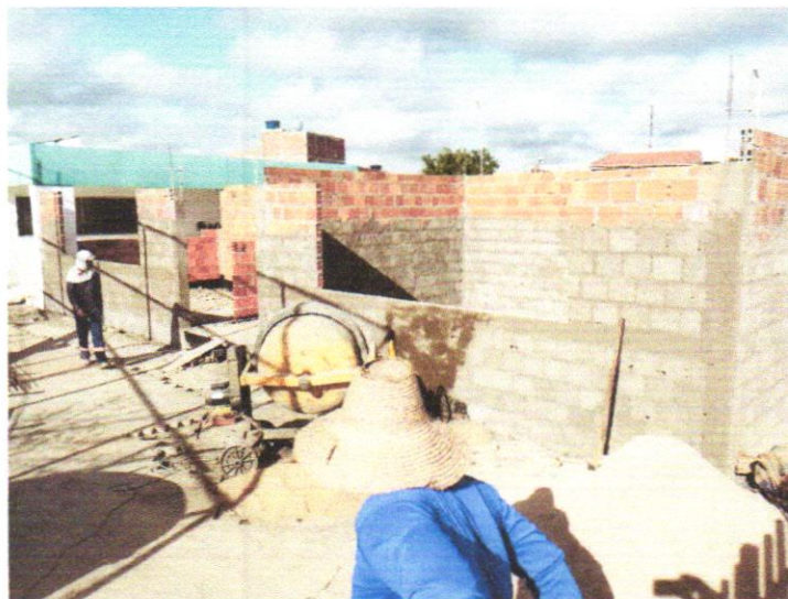
FOTO 06 - CONCRETAGEM DE PILARES, FCK = 25 MPa, COM USO DE BALDES - LANÇAMENTO, ADENSAMENTO E ACABAMENTO. AF_02/2022
