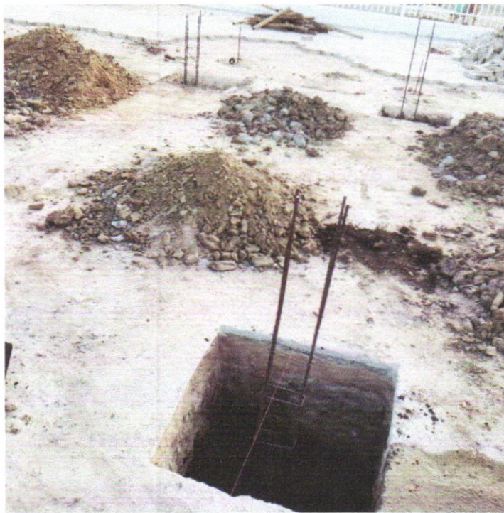
FOTO 05 - ARMAÇÃO DE PILAR OU VIGA DE ESTRUTURA CONVENCIONAL DE CONCRETO ARMADO UTILIZANDO AÇO CA-50 DE 10,0 MM - MONTAGEM. AF_06/2022
