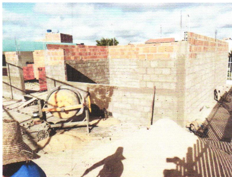
FOTO 04 - CHAPISCO APLICADO EM ALVENARIA (COM PRESENÇA DE VÃOS) E ESTRUTURAS DE CONCRETO DE FACHADA, COM COLHER DE PEDREIRO. ARGAMASSA TRAÇO 1:3 COM PREPARO EM BETONEIRA 400L. AF_10/2022
